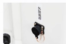
外部電源供給口
